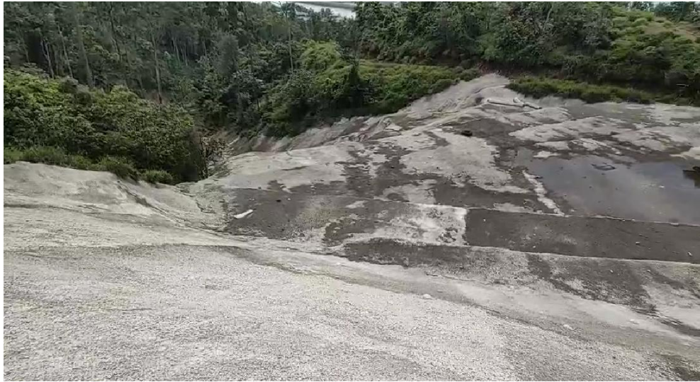
混凝土喷浆固化保护原土植被
